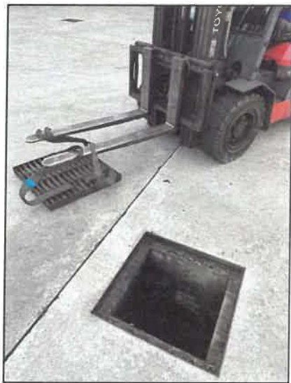
รูปที่ 3-15 การตรวจสอบและทำความสะอาดรางระบายน้ำฝน
