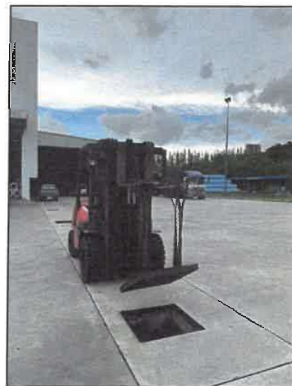
รูปที่ 3-15 การตรวจสอบและทำความสะอาดรางระบายน้ำฝน
